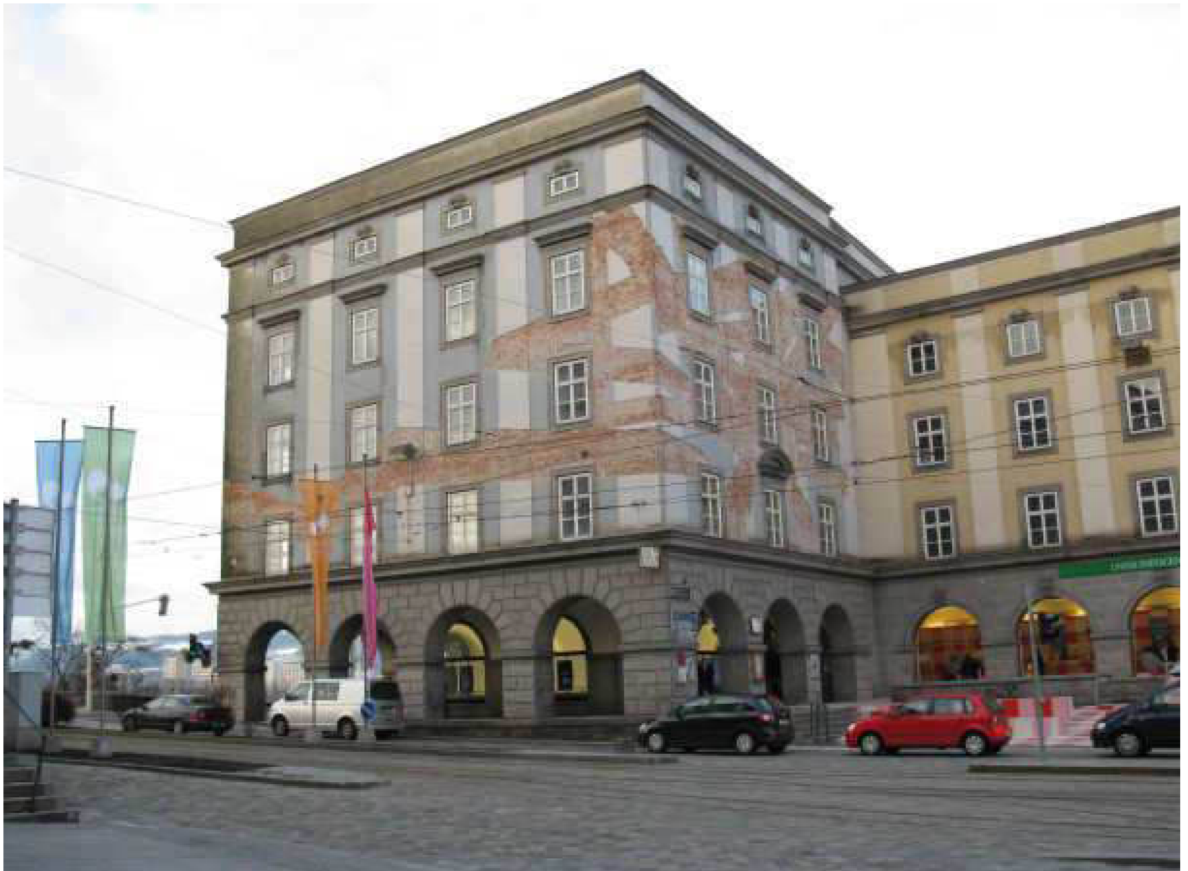
Abbildung 34: Linz, Fassadenabschlagung, Brückenkopfgebäude, 2009
